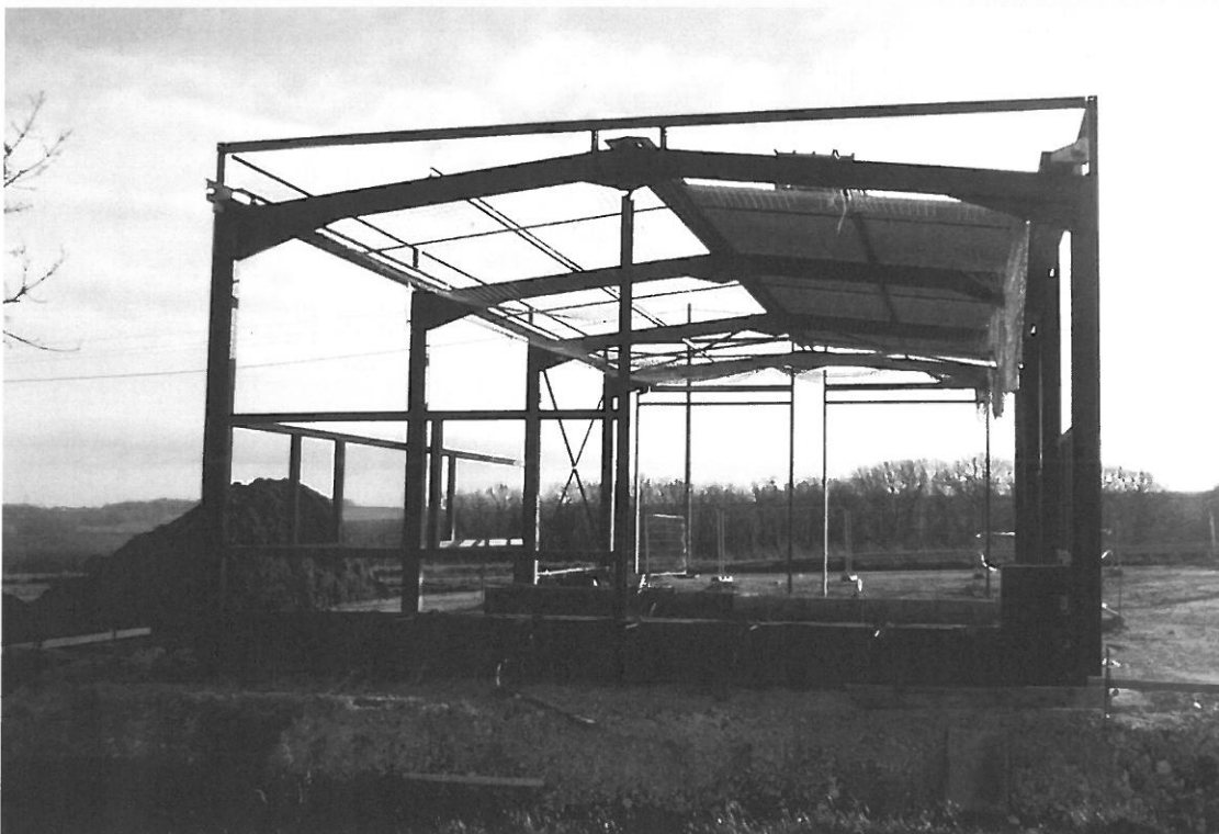
Le 16/01/2016 : une ossature métallique s' élève.
