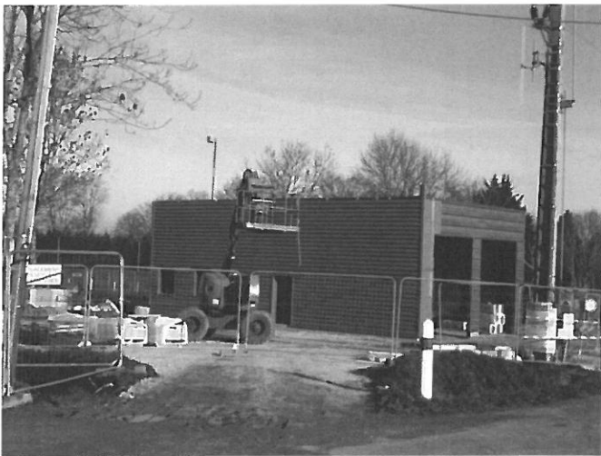
Le 30/01/2016 : on habille la structure d' une robe en tôle.
