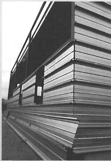
Le 30/01/2016 : on habille la structure d' une robe en tôle.
